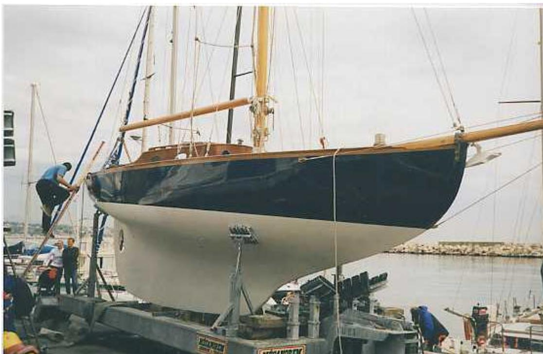
Remplacement de toutes les membrures et varangues par des nouvelles en lamellé-collé.
